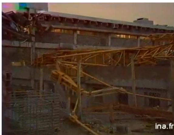
Fig. 14 : Toitures d'entreprise soufflées – Effondrement d'une grue de chantier (source : [www.ina.fr](http://www.ina.fr))
