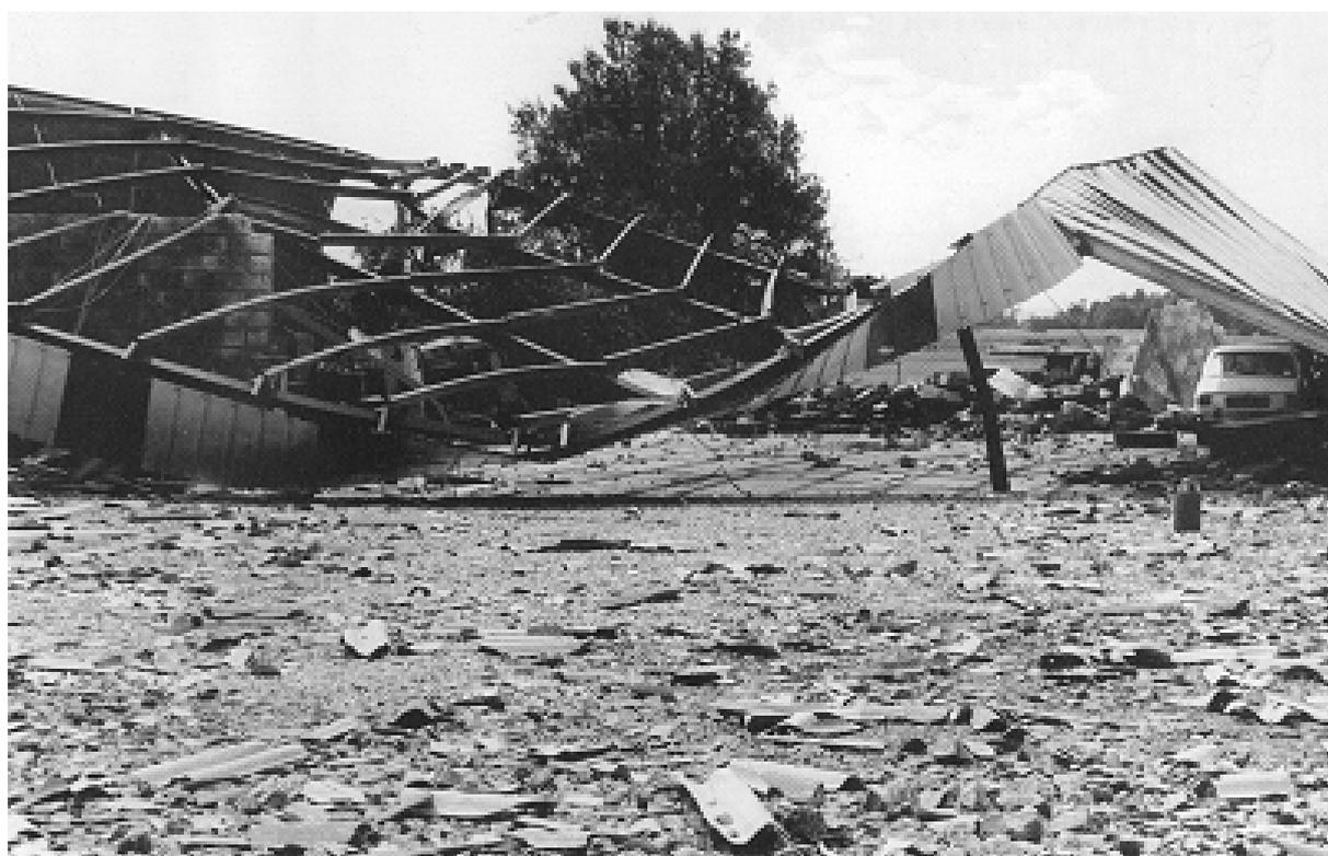
Fig 29 - Ce hangar du hameau de Romefort (Saint-Front, Charente) a été détruit. Les murs en parpaings sont pulvérisés. La structure métallique a même été tordue. © KERAUNOS
