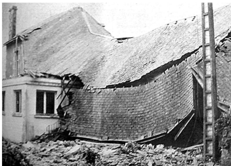
Fig. 32 : La toiture de la coopérative agricole de Charroux s'est effondrée, ce qui a entraîné la destruction d'un mur.
