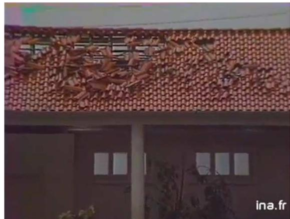
Fig. 13 : Toitures de l'agglomération niortaise endommagées avec chutes de tuiles (source : [www.ina.fr](http://www.ina.fr))
