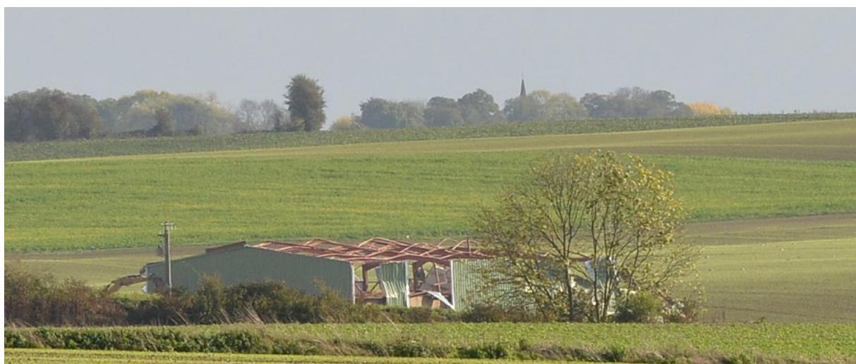
[1] Mory – Gros hangar métallique soufflé, route d'Ervillers. La structure s'est tordue sous l'effet du vent
