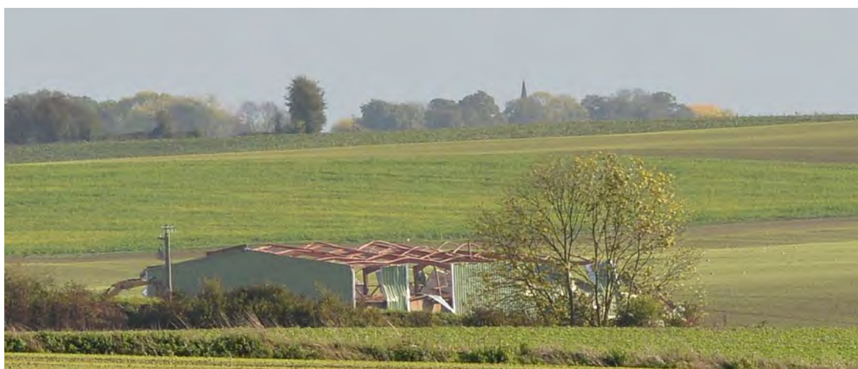
[1] Mory – Gros hangar métallique soufflé, route d'Ervillers. La structure s'est tordue sous l'effet du vent © Keraunos
