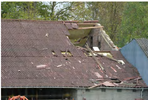
[8] Braffe – Portion de toiture (sous le vent) d'un hangar agricole arrachée, et emportée vers le NNO / (9) Croix d'une chapelle arrachée et emportée vers l'ONO, rue du Gros Tilleul © Keraunos
