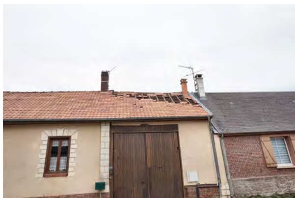
Belleuse – Exemple de tuiles arrachées sur une habitation / [2] Bois endommagé © G. Milcareck
