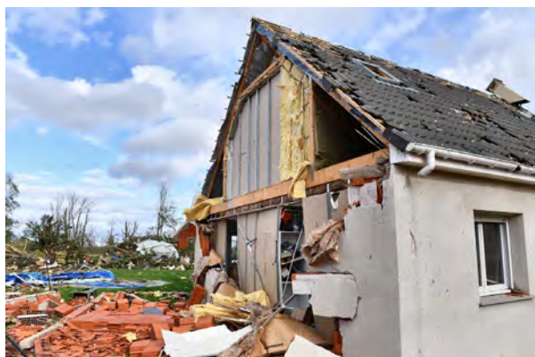
[3] Bihucourt – Pignon d’une habitation (3, rue Dorier) dont le mur porteur est arraché et emporté (à gauche) / Toiture entièrement arrachée (5, rue Dorier) et bâtiment éventré jusqu’au sol (à droite) © Keraunos
