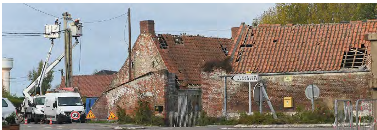
[3] Warlaing – Techniciens occupés à rétablir l'électricité à l'intersection des rues Grande et Firmaine © Keraunos
