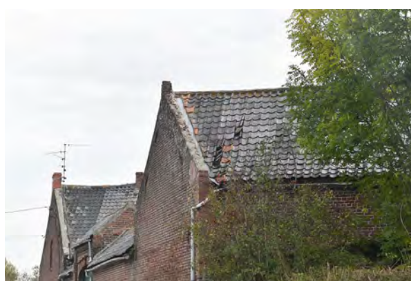
[1] Lecelles – Illustration de branches arrachées au Point du Jour / [2] Tuiles délogées sur un bâtiment de ferme, rue des Fèves © Keraunos
