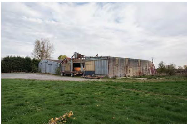
[2] Le Hamel – Portion de toiture d'un hangar arrachée, rue Notre-Dame-du-Hamel © G. Milcareck / Le même toit propulsé 40 mètres vers le nord, entraînant dans sa chute un câble électrique © Le Réveil
