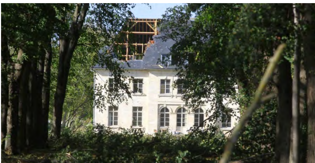
[5] Ô-de-Selle – Élément de toiture du château de Tilloy-lès-Conty arraché © Courrier Picard
