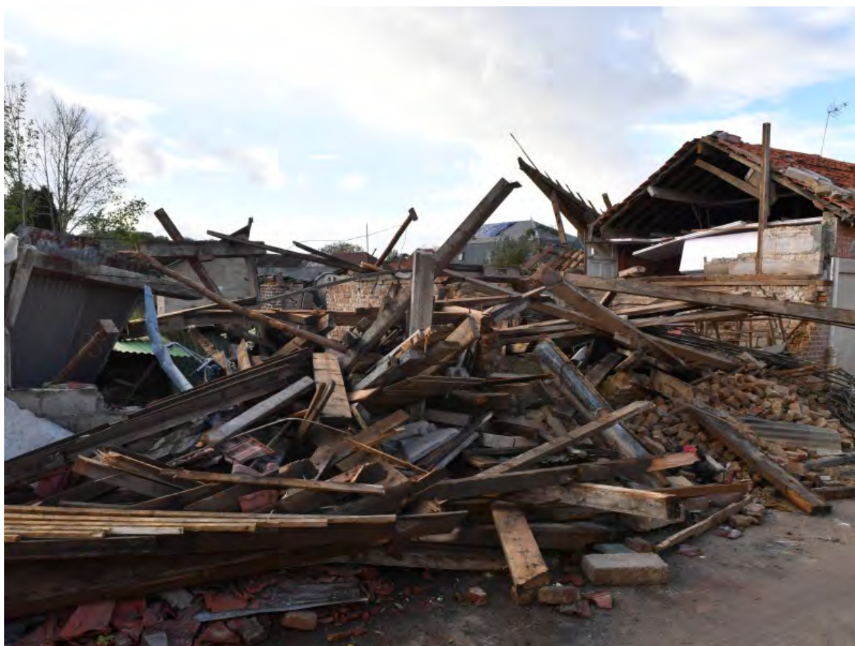
[4] Solide dépendance de ferme démolie, rue du Moulin © Keraunos
