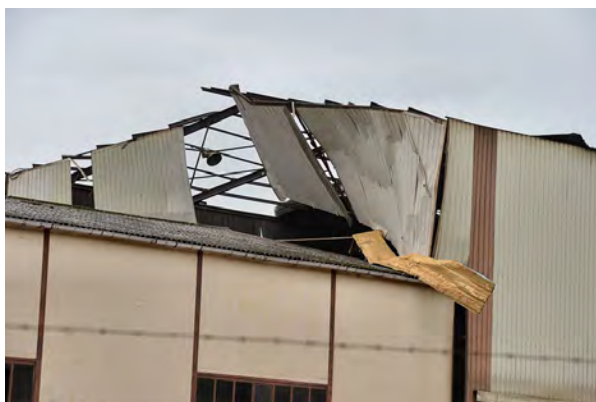
[4] Songeons – Arbre vigoureux sectionné dans la zone artisanale / Toiture de l'usine Agriform partiellement arrachée et transportée à 300 mètres © Keraunos
