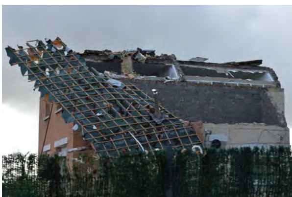
[3] Bihucourt – Aperçu d’une maison (arrière du n°14, rue de la Cité) vue par la rue du Centre : toiture en grande partie détruite (à gauche) / Toiture arrachée (rue de la Cité) et murs écrêtés aux étages supérieurs (à droite) © Keraunos
