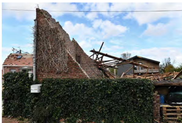
[3] Bihucourt – Pignon d’une habitation (3, rue Dorier) dont le mur porteur est arraché et emporté (à gauche) / Toiture entièrement arrachée (5, rue Dorier) et bâtiment éventré jusqu’au sol (à droite) © Keraunos
