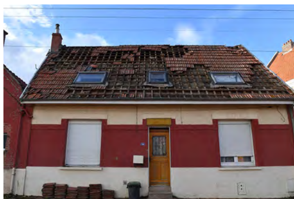
[3] Vitres d'un abribus explosées à côté de l'église / Tuiles emportées sur une toiture au n°34, Grand'Rue © Keraunos
