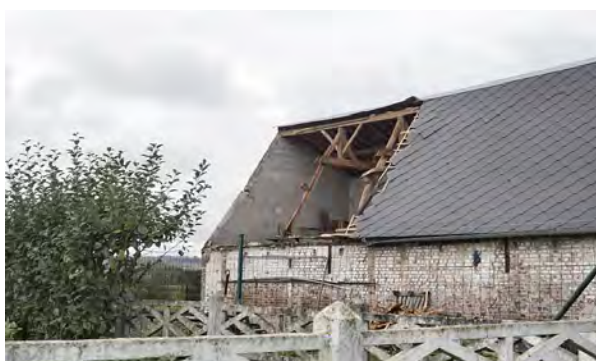
[1] Gournay-en-Bray – Branche brisée dans la vallée de l'Epte / [2] Ferrières-en-Bray – Pan de toiture arraché, chemin du Grand-Pré © G. Milcareck
