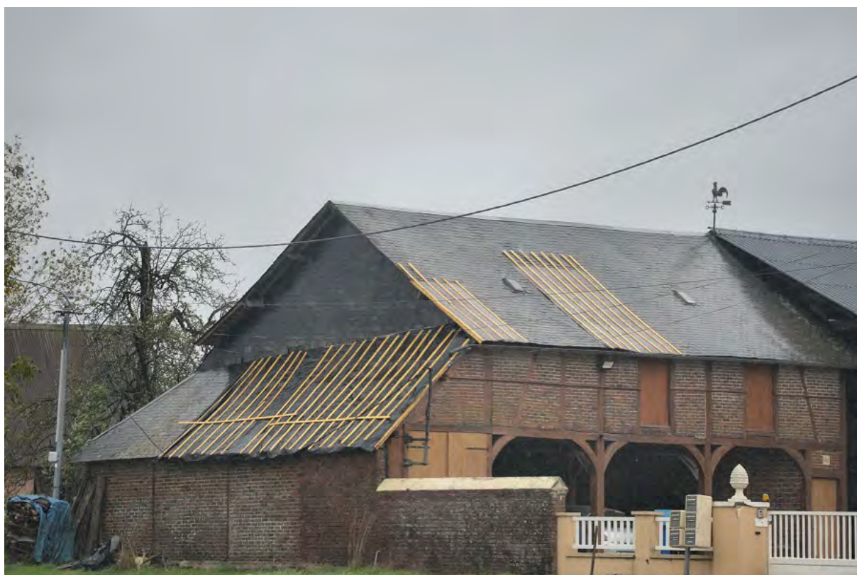
[5] La Neuve-Grange – Toiture d'un bâtiment agricole en réparation, impasse du Marronnier © Keraunos
