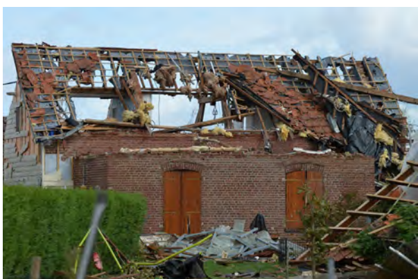
[3] Bihucourt – Aperçu d’une maison (arrière du n°14, rue de la Cité) vue par la rue du Centre : toiture en grande partie détruite (à gauche) / Toiture arrachée (rue de la Cité) et murs écrêtés aux étages supérieurs (à droite) © Keraunos
