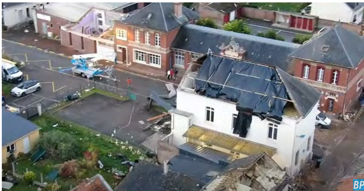
[1] Conty – Vue d'ensemble de la Poste, de l'école et du CMPP du Val de Selle (en haut à gauche), où le toit est totalement arraché. Les débris sont déjà en bonne partie nettoyés © Sdis 80
