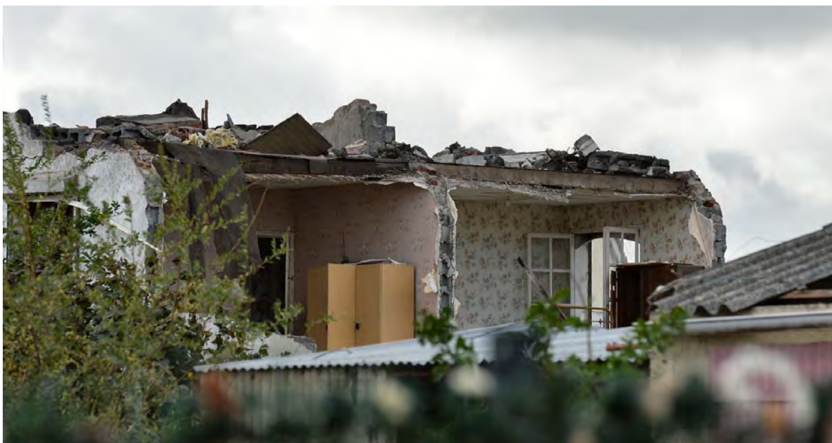
[3] Bihucourt – Toiture entièrement arrachée, murs extérieurs aspirés aux étages supérieurs (rue du Centre) © Keraunos
