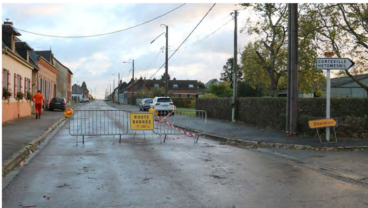
[2] Beaudéduit – Fermeture temporaire de la D124 en raison de chutes de câbles électriques © Le Réveil
