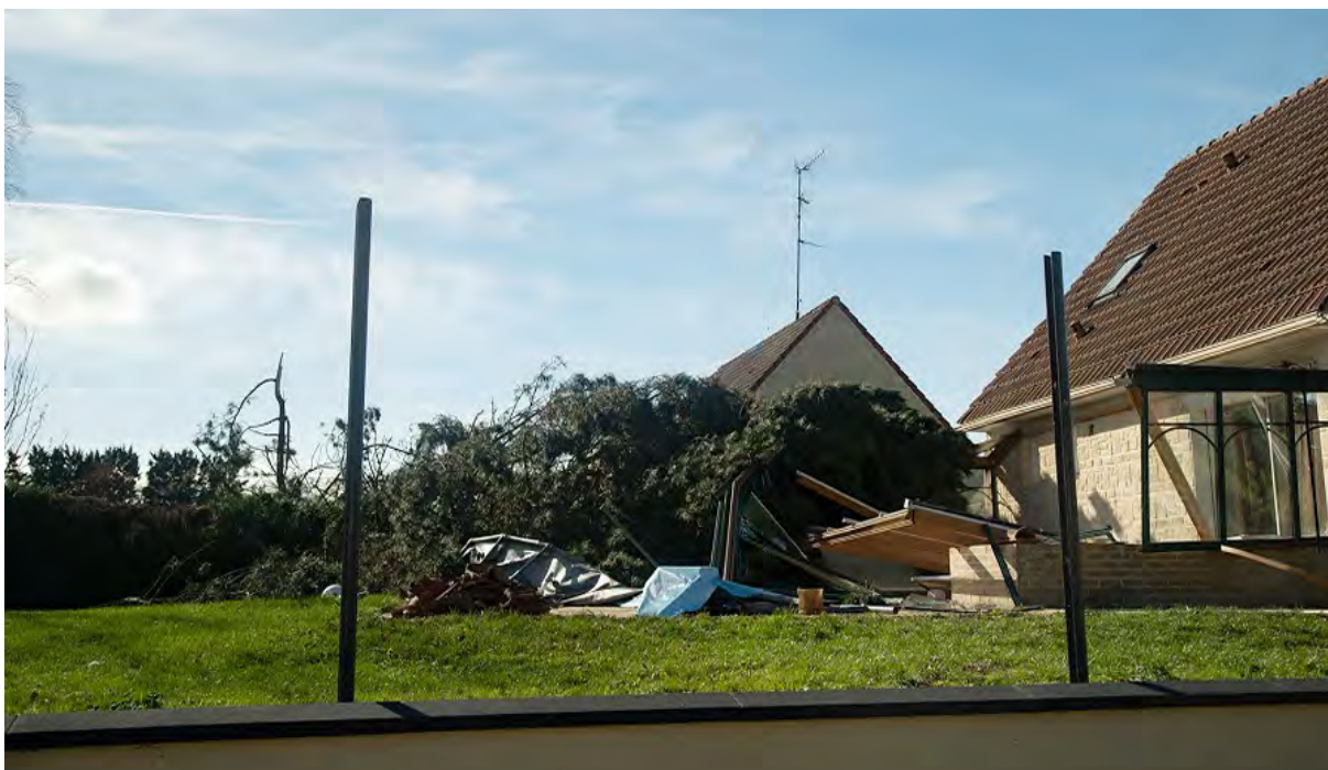
[1] Récourt – Conifère déraciné, véranda détruite et clôture en palissades soufflée, voie du Curé © C. Asselin
