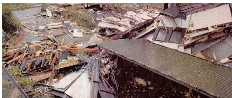
voilà ce qu'il reste de la classe en préfabriqué après le passage de la tornade (photo : La Voix du Nord – Dunkerque)
